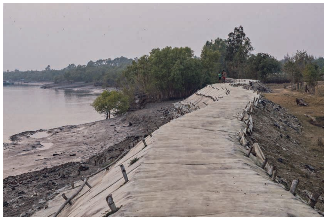
La digue récemment refaite, un rempart contre les éléments naturels, 2026
