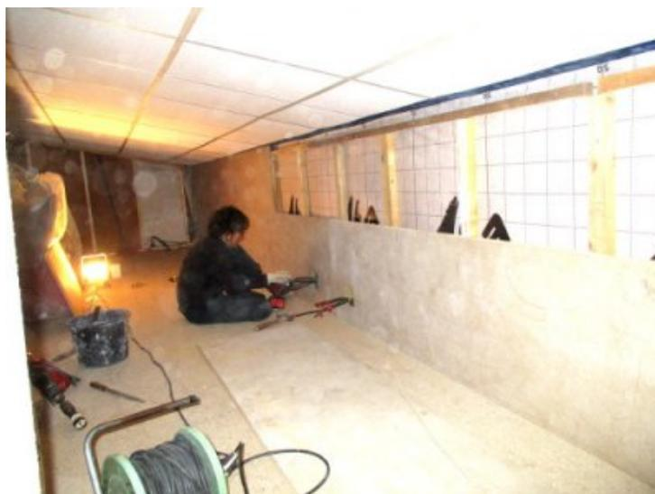
**Photo 25 - Avril - Mezzanine sous pente - Couverture de l'isolation à l'aide de panneaux de bois et électricité.**
