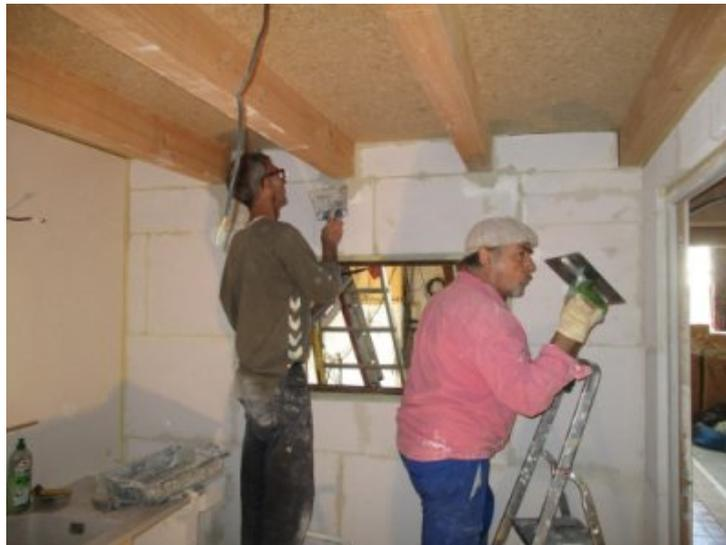
Photo 18 - Cuisine - Enduit sur le béton cellulaire
