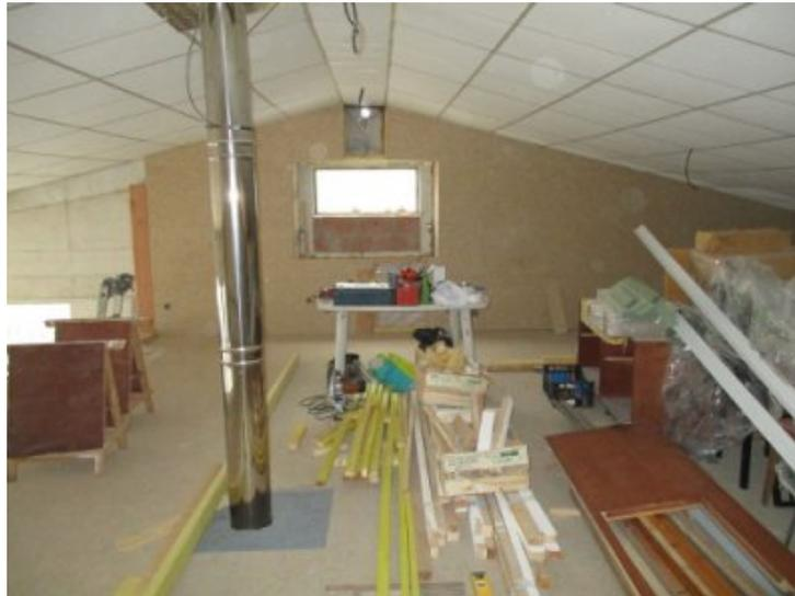
**Photo 24 - Avril - Mezzanine - Isolation murs recouverts de panneaux de bois OSB et fenêtre en attente d'être changée.**
