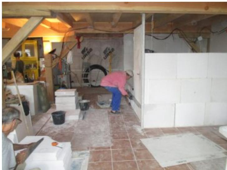
Photo 16 - Juin - Cloisons en béton cellulaire pour WC et cuisine
