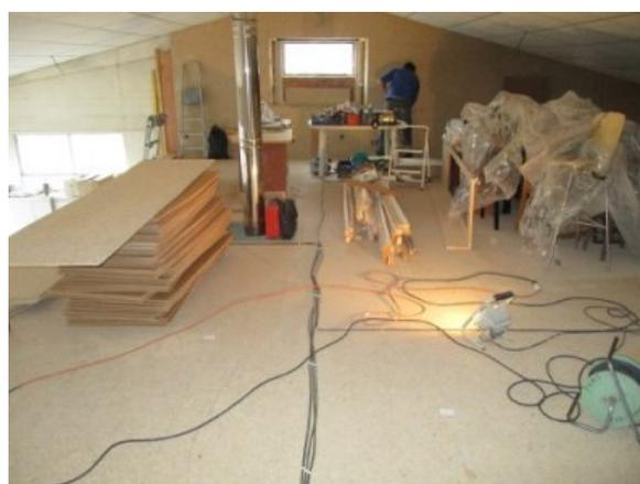
**Photo 23 - Mai - Mezzanine - Au sol panneaux de bois OSB et fils électriques qui seront recouverts par des**
