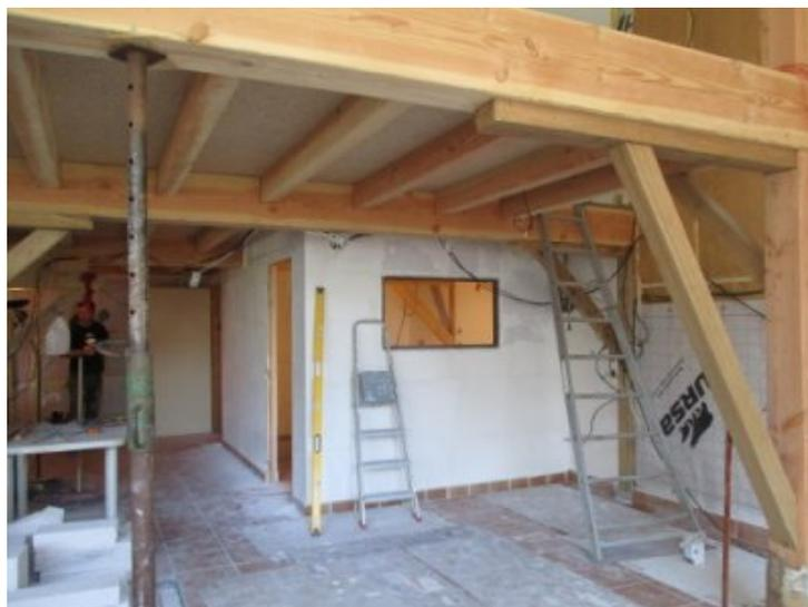
Photo 19 - Cloisons WC/cuisine et toujours l'échelle à droite pour accéder à la mezzanine
