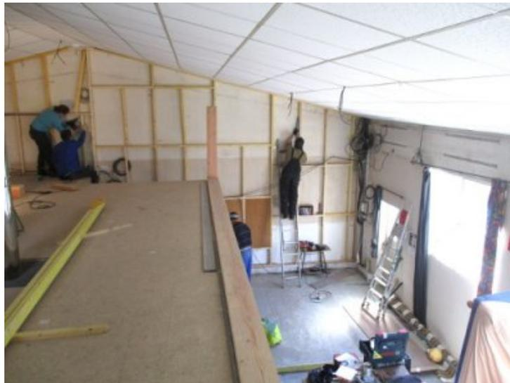
**Photo 21 - Avril - Isolation (structure bois) mezzanine et au RDC**
