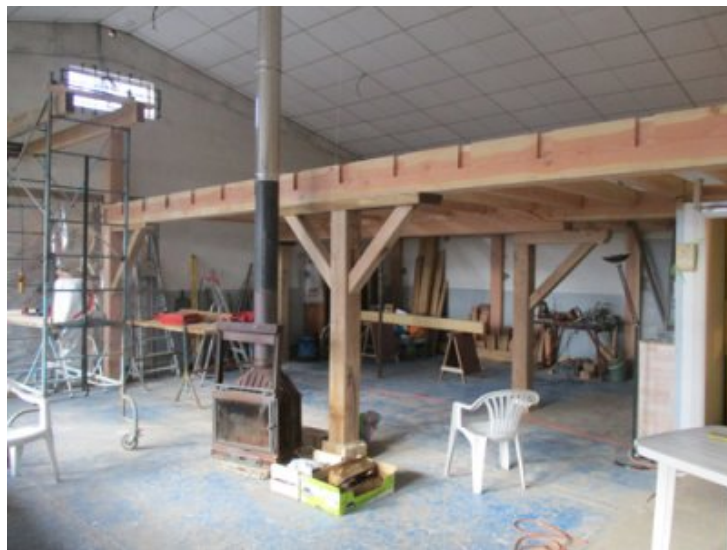
Photo 13 - 19 déc. - Les poutres A, B et C sont installées. Aisseliers, paumes et solives sont visibles.
