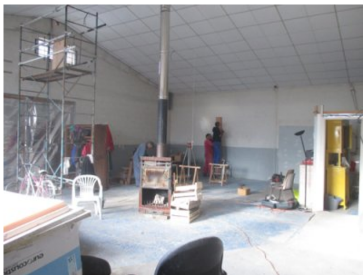
Photos 5 et 6 - 23 nov. - Coffrages, béton et mise en place des premiers poteaux.
