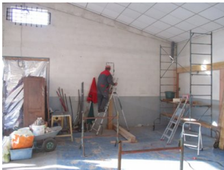
Photo 7 - 4 déc. - Travaux pour poutre B - A droite poutre A installée.
