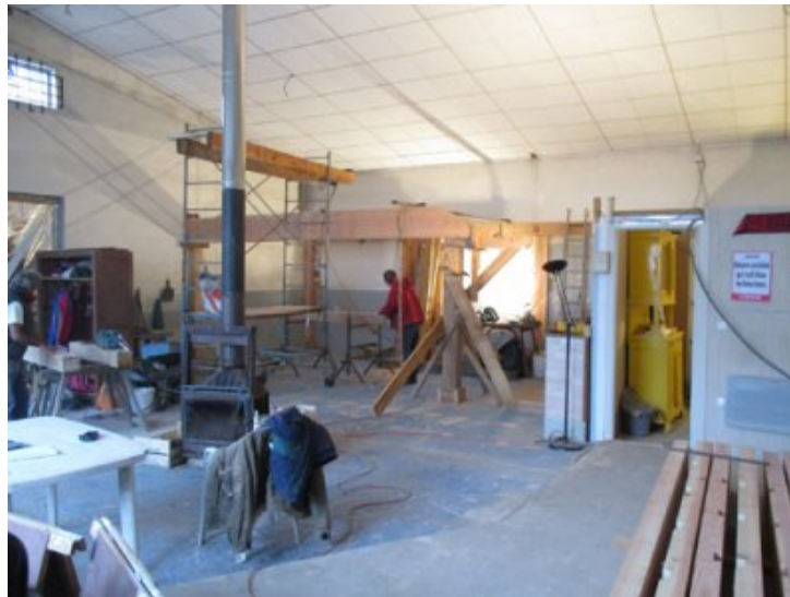
Photo 9 - 8 déc. - La moitié de la poutre B est en place. On aperçoit au milieu la moitié du sifflet et l'aisselier qui va soutenir la poutre. En bas à droite de l'image des poutres avec les paumes pour les solives.
