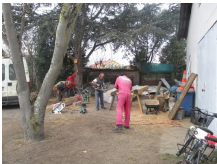
Photo 8 - 7 déc. - L'atelier est partout.
