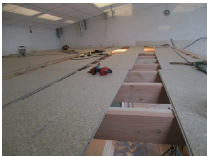
Photo 14 - 21 déc. - Premier plancher de la mezzanine sur les poutres A, B et C et sur les solives.
