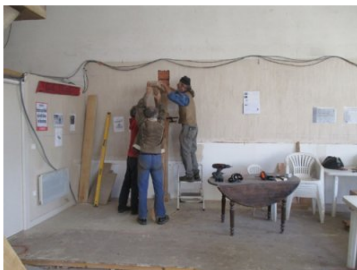
Photos 11 et 12. Poutre C - Mise en place de l'aisselier et installation de la seconde partie de la poutre à l'aide de l'échafaudage et du palan.
