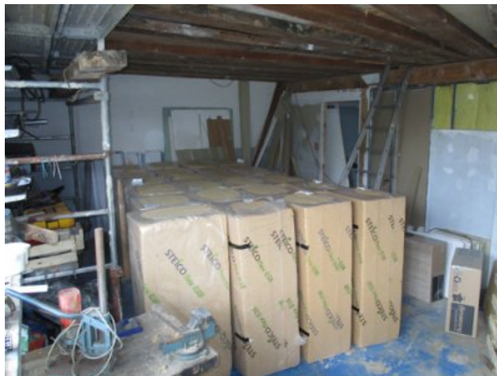
photo 3 : ballots d'isolants de 12 et 14 cm
