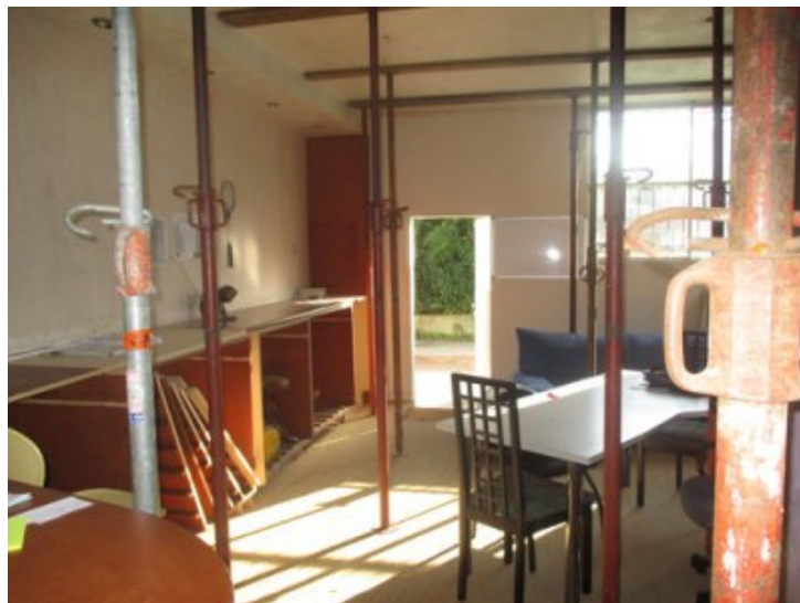
Photo 8 : Entrée principale du local.
