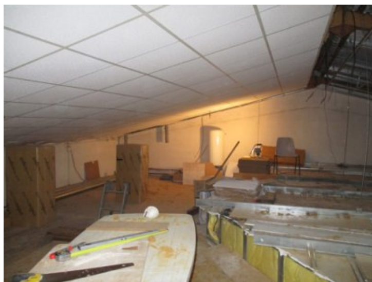
photo 4 - partie gauche du toit terminée
