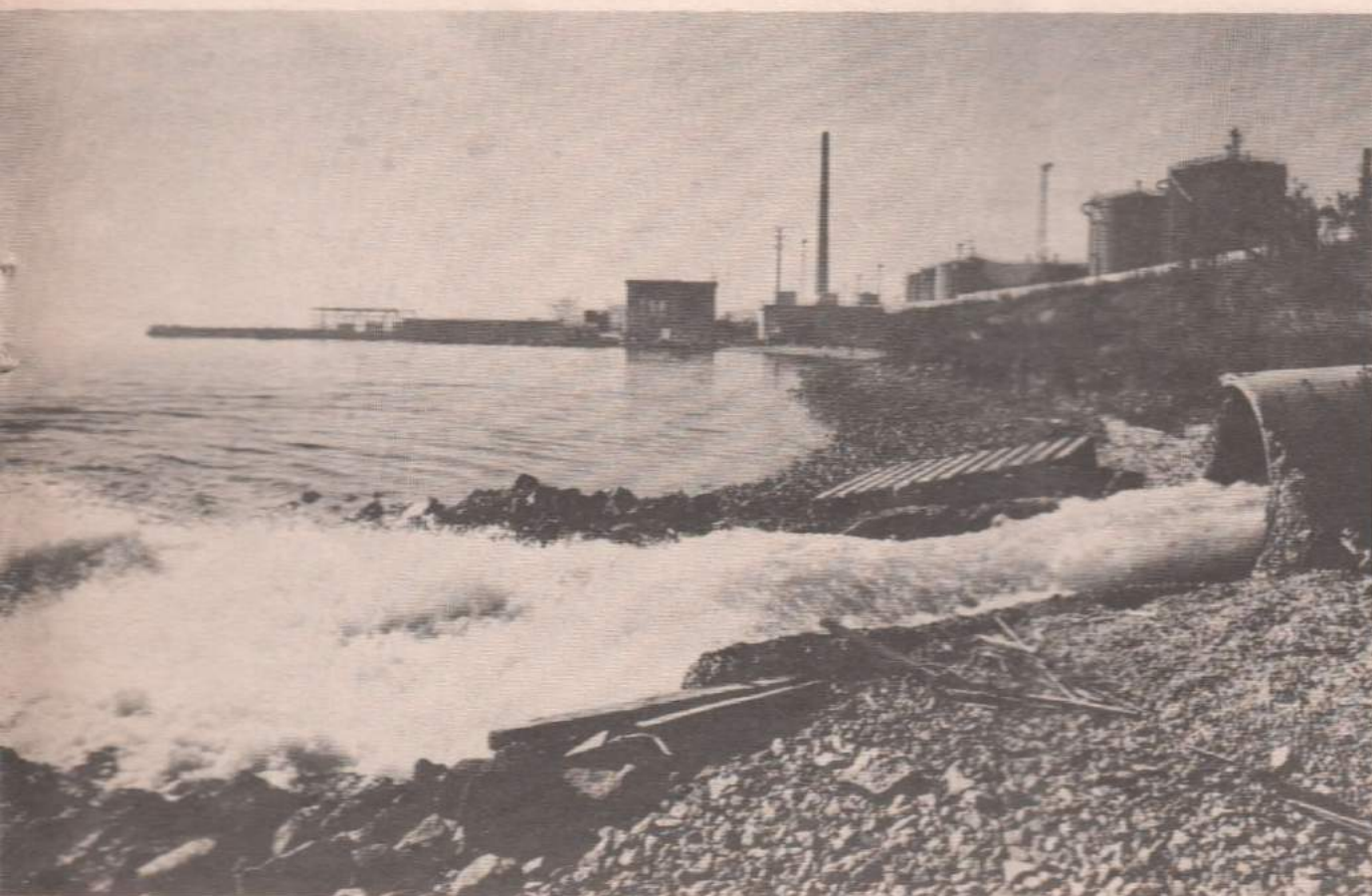
Déversoir de Shell dans l'étang de Berre.
