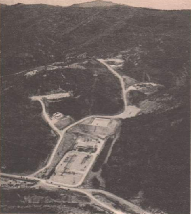
Stockage souterrain de produits pétroliers à Manosque en Haute-Provence. De telles installations, tout en s'inscrivant parfaitement dans le site, permettent d'assurer une efficace protection contre les nuisances.
