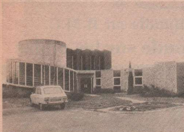
Le Centre Informatique : un bâtiment bien tranquille.
