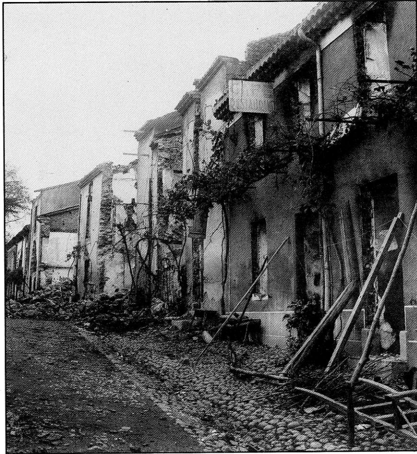
Sur les façades du Café-Restaurant FONT et des immeubles voisins, les treilles ont résisté à l'incendie
