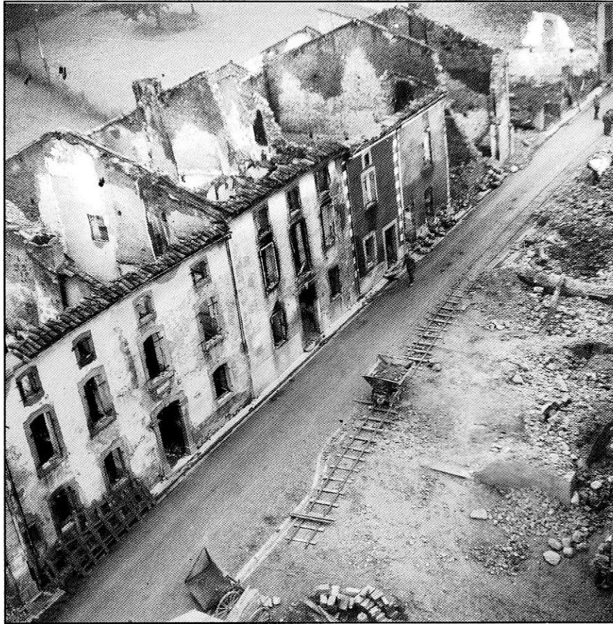
Les ruines de l'avenue de la Bielle où une voie Decauville et ses wagonnets ont été installés
